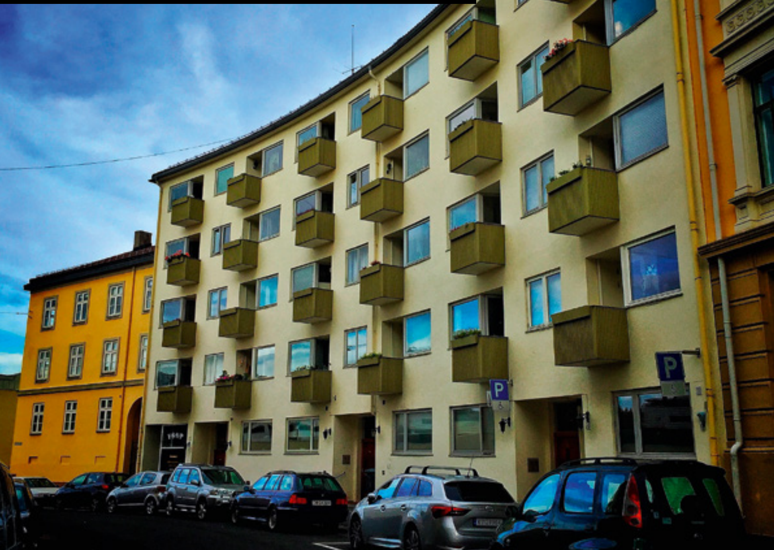
Beboerne i Bennechesgate 5 i Oslo skal utbedre brannsikkerheten.
