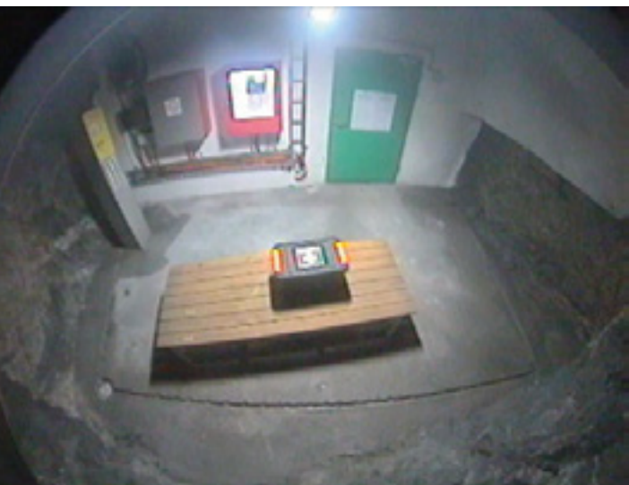
Foto: Follo brannvesen IKS Et av nødrommene man kan redde seg inn i under en brann.
